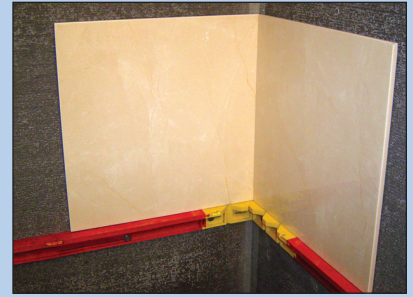
Coloque las baldosas encima del StringA-Level™
