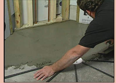
Fill with mud Llene con la mezcla (mortero)
